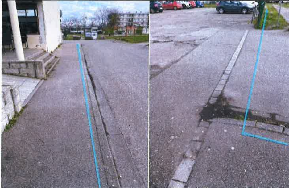
POSE DE 3 PEHD Ø40 Tranchée traditionnelle sur trottoir + chaussée ( 6 ml ) Rambotai avec extrait - Réfection en ENROBE
