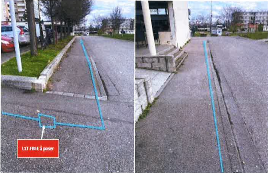
POSE DE 3 PEHD Ø40 + 1 LIT FREE Tranchée traditionnelle sur trottoir Rombial avec extrait - Réfection en ENROBE
