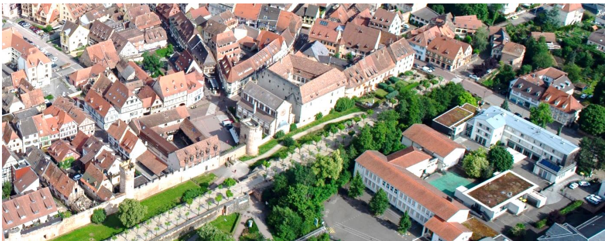
Photo depuis le parking de l'établissement scolaire Freppel illustrant la proximité avec le rempart Est
